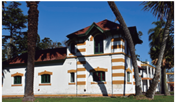
Vista Lateral del edificio
